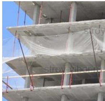
защитно-улавливающие сетки (ЗУС)
