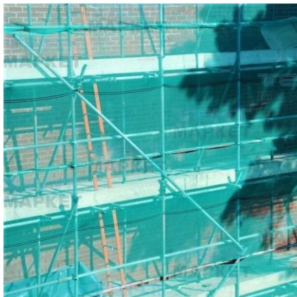
защитно-улавливающие сетки (ЗУС)
